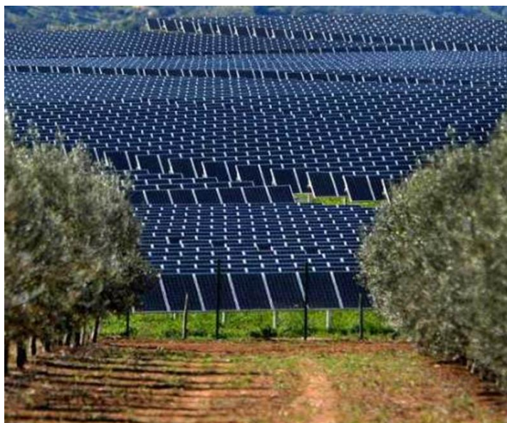
Fig.1 - Energia renovável na Amareleja
